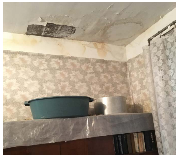
სურათი 8. საცხოვრებელ კორპუსებში ნაღების ჩამოსვლის შედეგად დაზიანებული ჭერი
