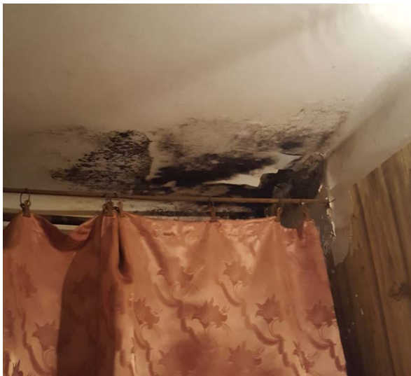
სურათი 8. საცხოვრებელ კორპუსებში ნაღების ჩამოსვლის შედეგად დაზიანებული ჭერი
