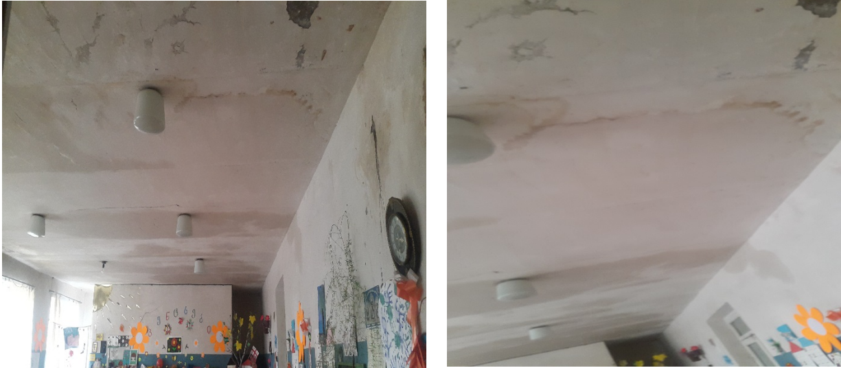
სურათი 7. №2 სკოლამდელი აღზრდის დაწესებულების დაზიანებული ჭერი
